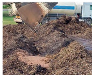
Figura 4 - Construção da pilha - Deposição bagaço húmido na vala definida com as folhas
